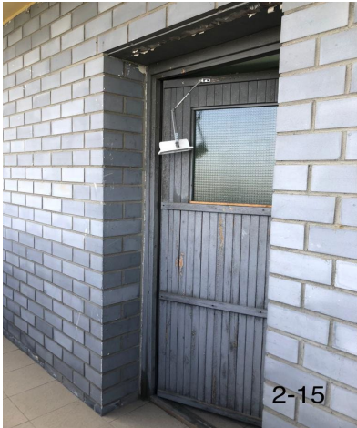
10) 07.09.23 На 15-м этаже закреплён оторванный доводчик.
