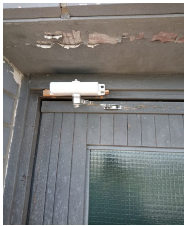
10) 07.09.23 На 15-м этаже закреплён оторванный доводчик.
